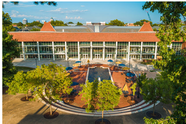
Moran Commons - Fountain View
